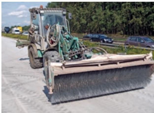
Herstellung der Waschbetonoberfläche durch Ausbürsten ↑
