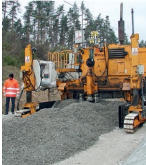
↑ Einbau der HGT mit einem Gleitschalungsfertiger
