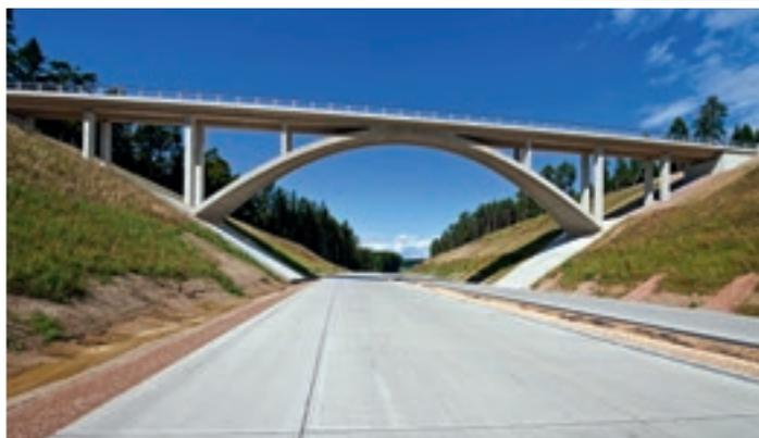
↑ Fahrbahndecke aus Beton und Bogenbrücke,
