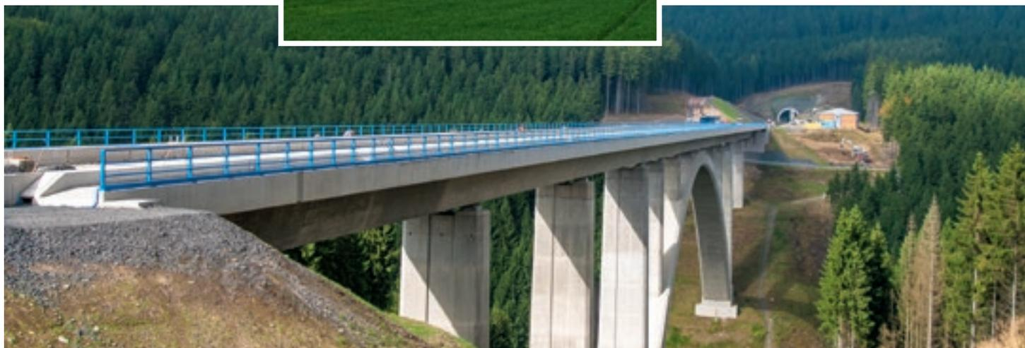
Alle sichtbar bleibenden geschalteten Flächen werden nach ZTV-ING mindestens in der Sichtbetonklasse SB2 ausgeführt.
